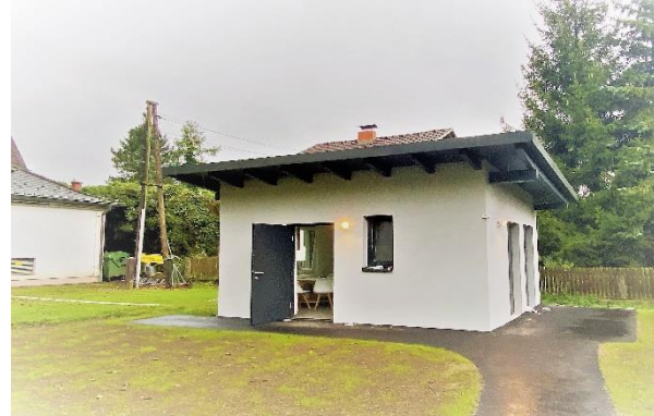
Errichtung Zubau zur effizienteren Nutzung der evangelischen Kirche Krumpendorf
