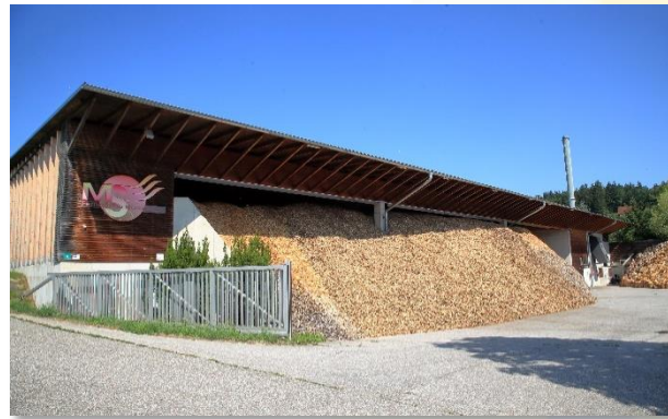
Anschluss an die Fernwärme Moosburg im Pfarrhaus Moosburg
