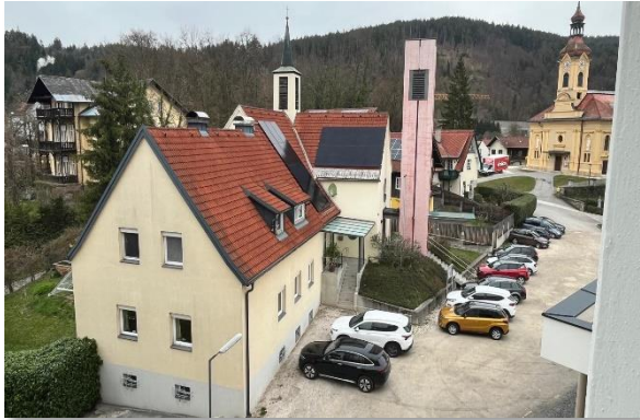
PV-Anlage auf der evangelischen Kirche und dem Pfarrhaus in Pörtschach
