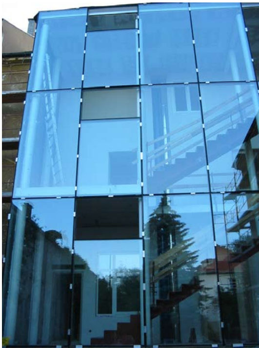
modern gestalteter Zubau des Gebäudes Villach Mitte
